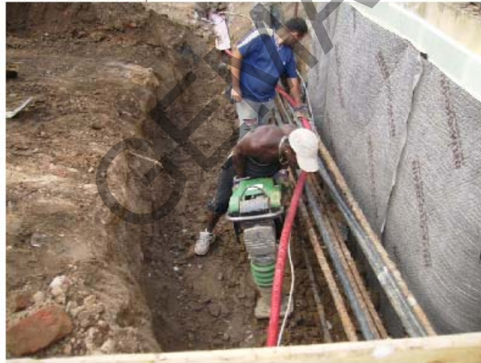
Obr.2 – hutnění 2.vrstvy
