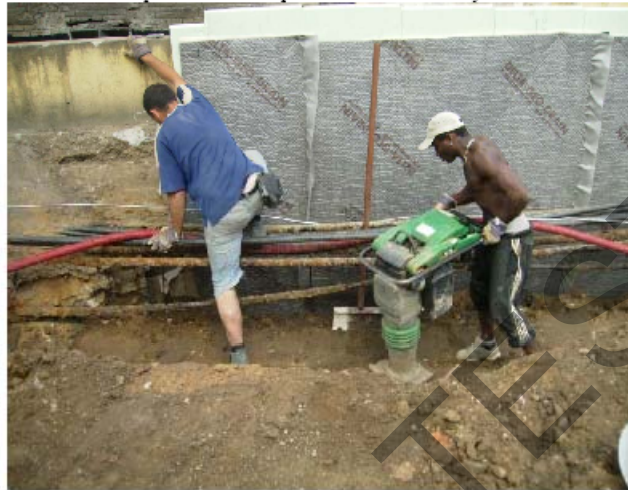
Obr. 4 – kontrola hutnění vrstvy LDD
